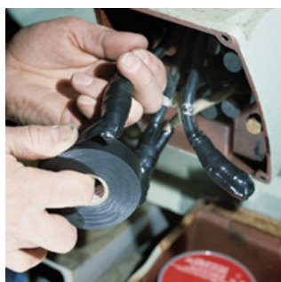
Figura 5 Acabado final del método recomendado en la Tabla 1 para motor de BT
