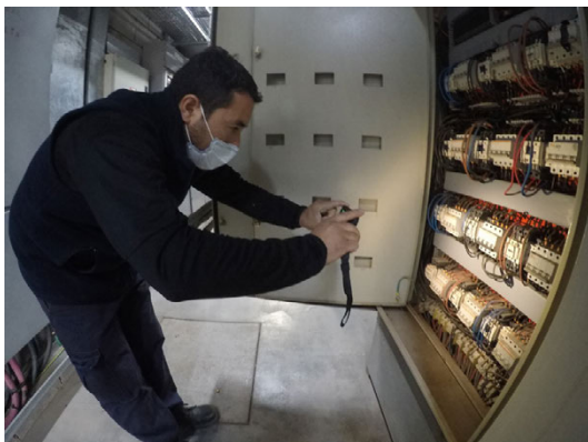
Personal evaluando comportamiento térmico con cámara termográfica.
